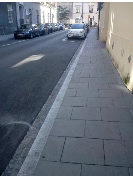
Wyremontowany fragment ul. Skawińskiej
